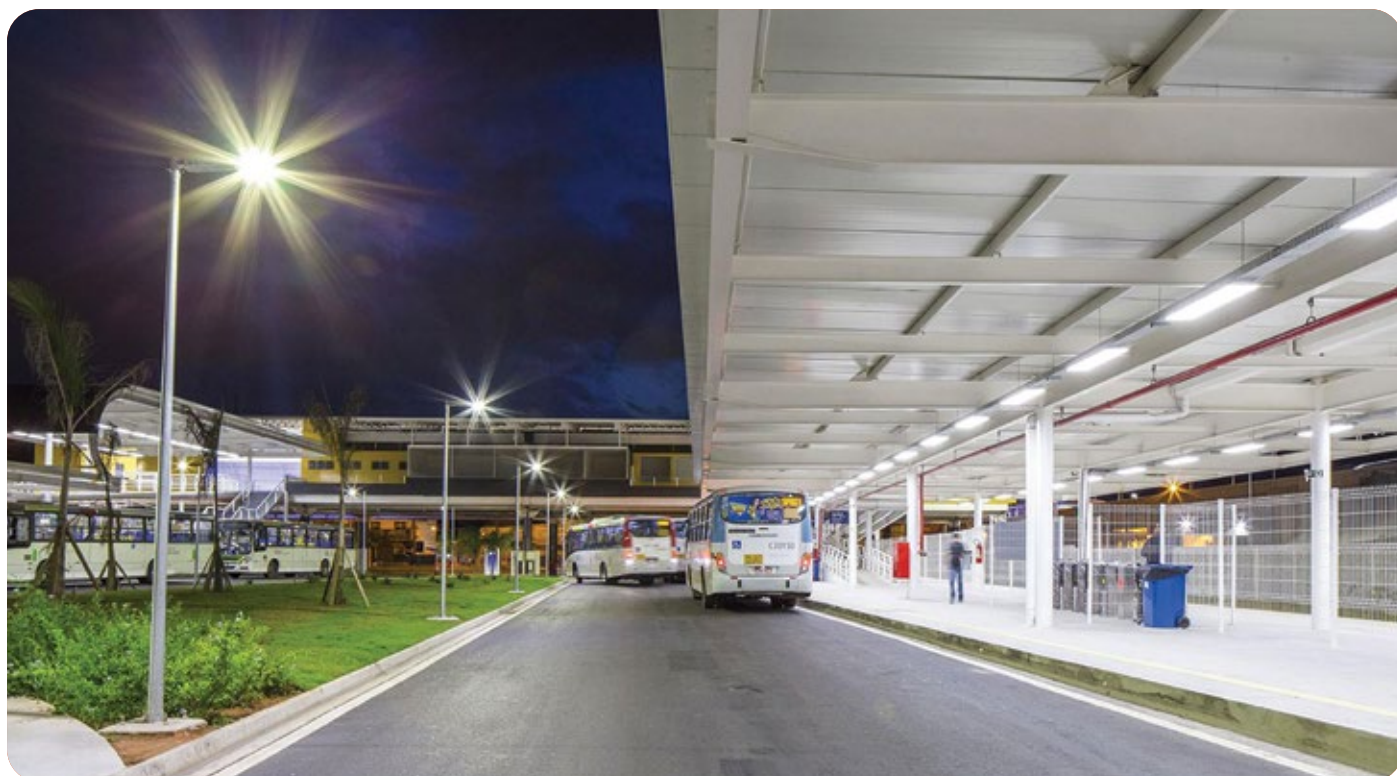
Terminal Sulacap | Rio de Janeiro - RJ
